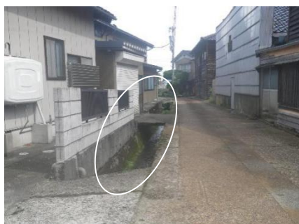
△水路への転落防止網の設置
