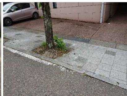
△修繕箇所③
