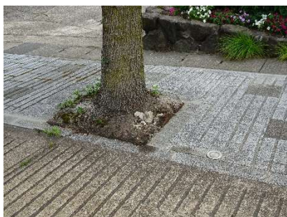
△ 修繕箇所① -西下公民館前-
