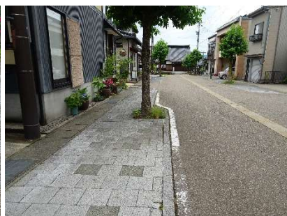
△ 修繕箇所②
